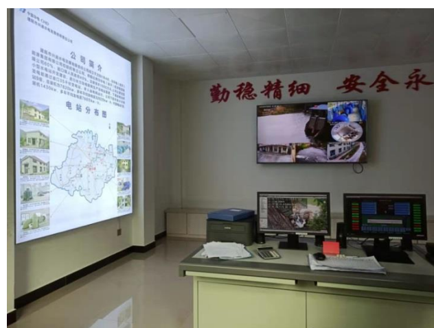
集控中心（下泄流量监控）
