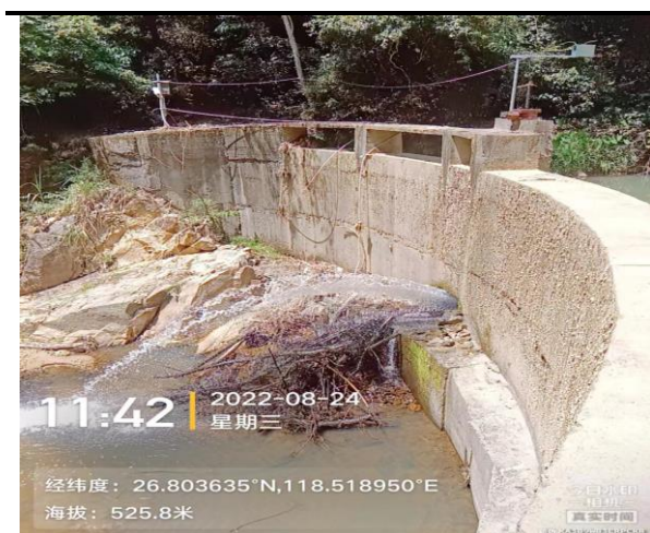
深溪拦河坝、监控摄像头、下泄流量口
